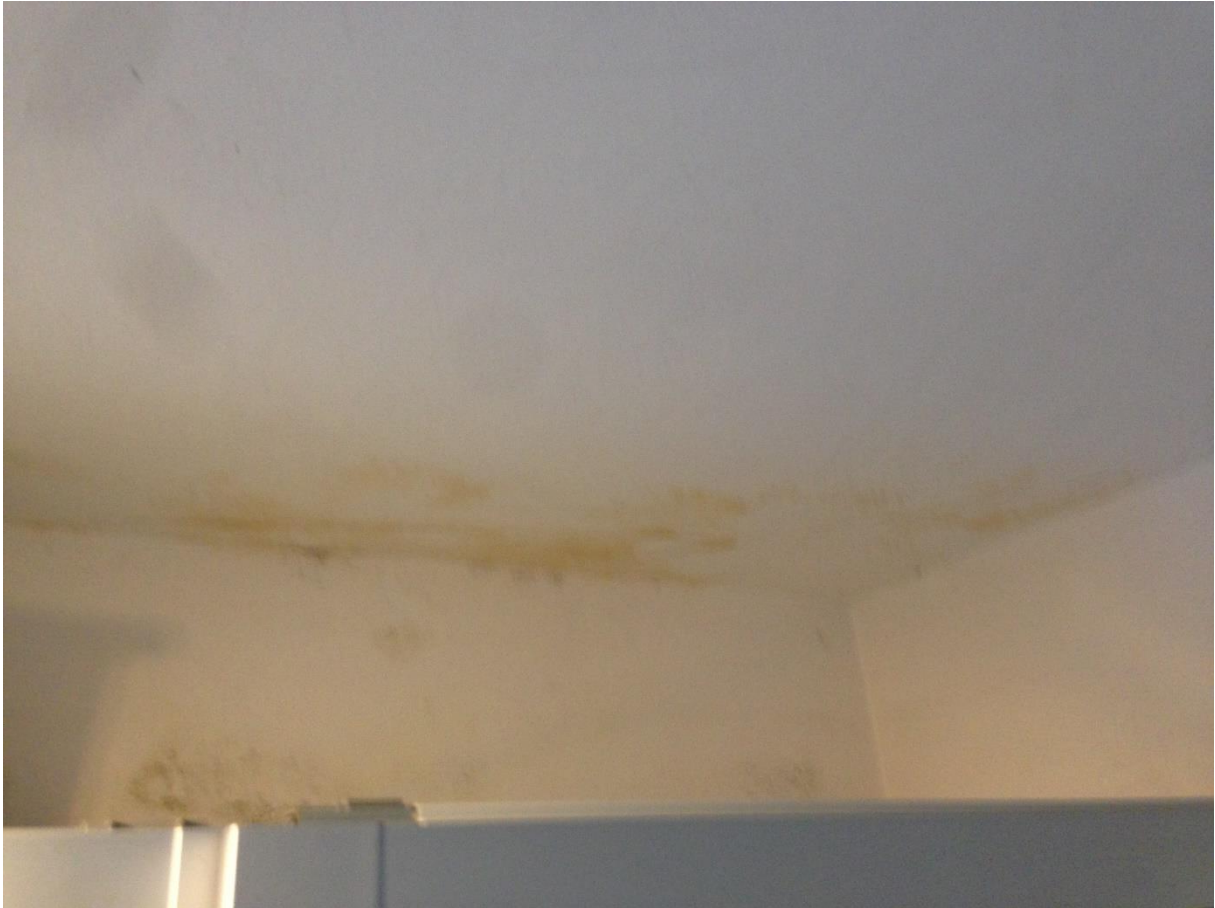
Slaapkamer plafond 3 – detail lekkage
